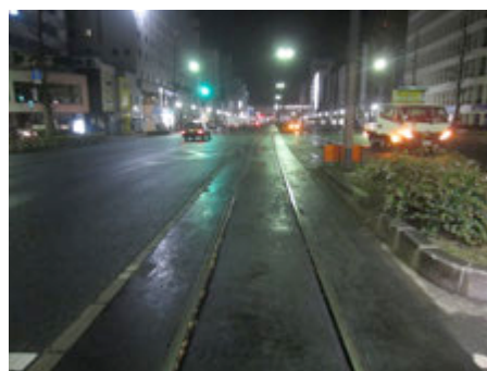
<西川橋上上り（修繕後）>
